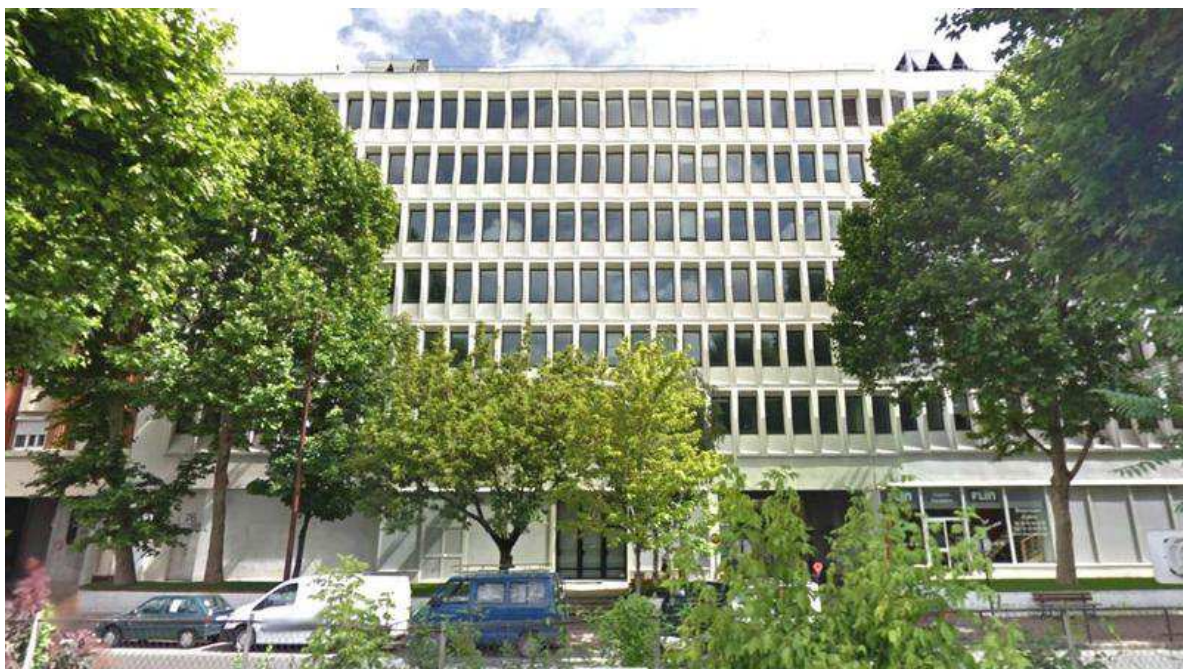
Avant travaux, une barre froide comme il en existe beaucoup. Crédits photo : Agence Moatti-Rivière
