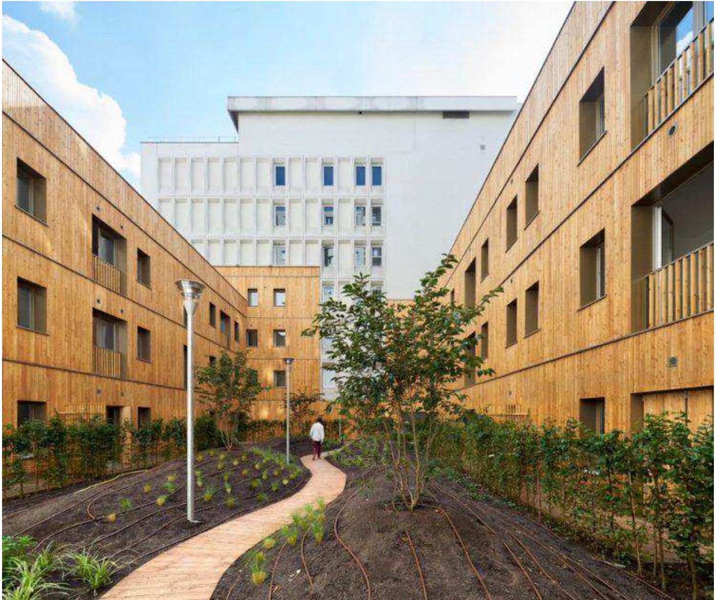
Logements Charenton Moatti-Rivière @Michel Denancé
