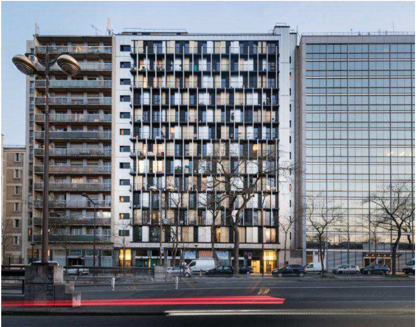
transformation d'un IGH bureaux en 60 logements @Baptiste Lobjoy
